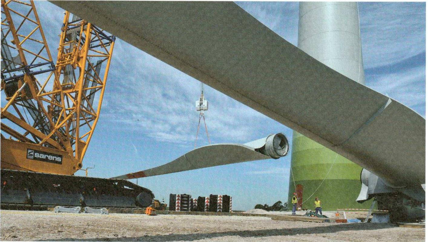
Nachdem Fundament und Turm aufgebaut sind, werden die Rotorblätter zur Montage an der Nabe vorbereitet.
