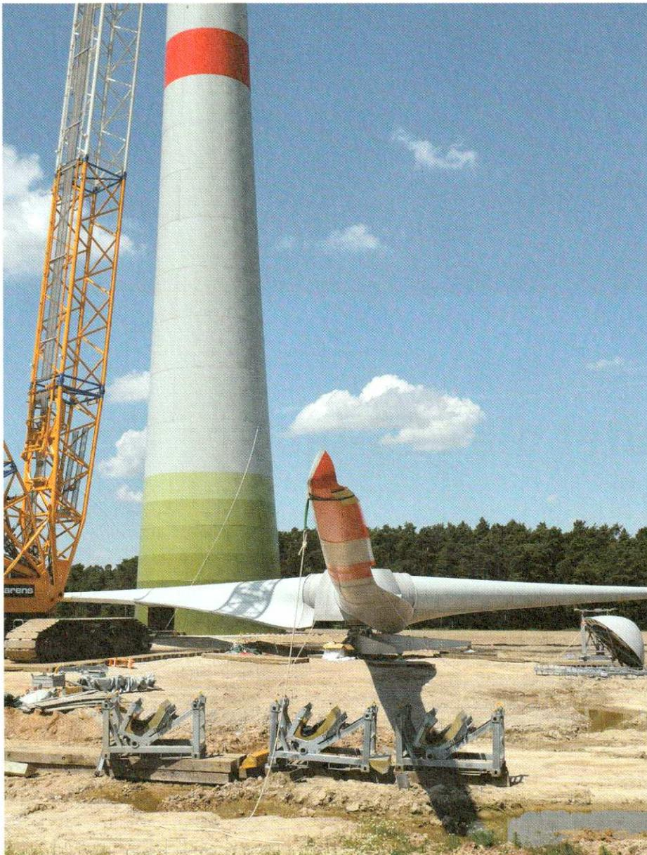
Das fertige Bauteil aus Rotorblättern und Nabe hat ein Gesamtgewicht von mehreren hundert Tonnen und muss anschließend in einem Stück am Turm montiert werden.
