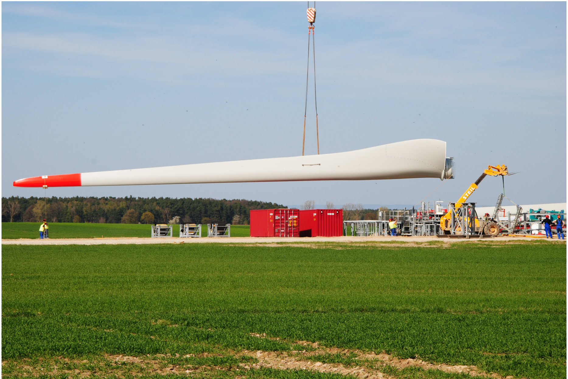
Der erste schwebende Flügel, hier beim Abladen vom Tieflader. 20
