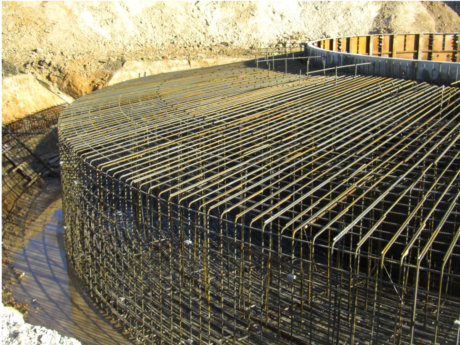
Armierung und Schalung des Fundamentkörpers
