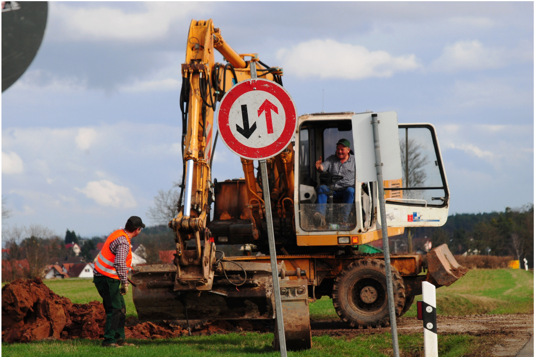
Baggerarbeiten für Startgrube der Kabelplügearbeiten
