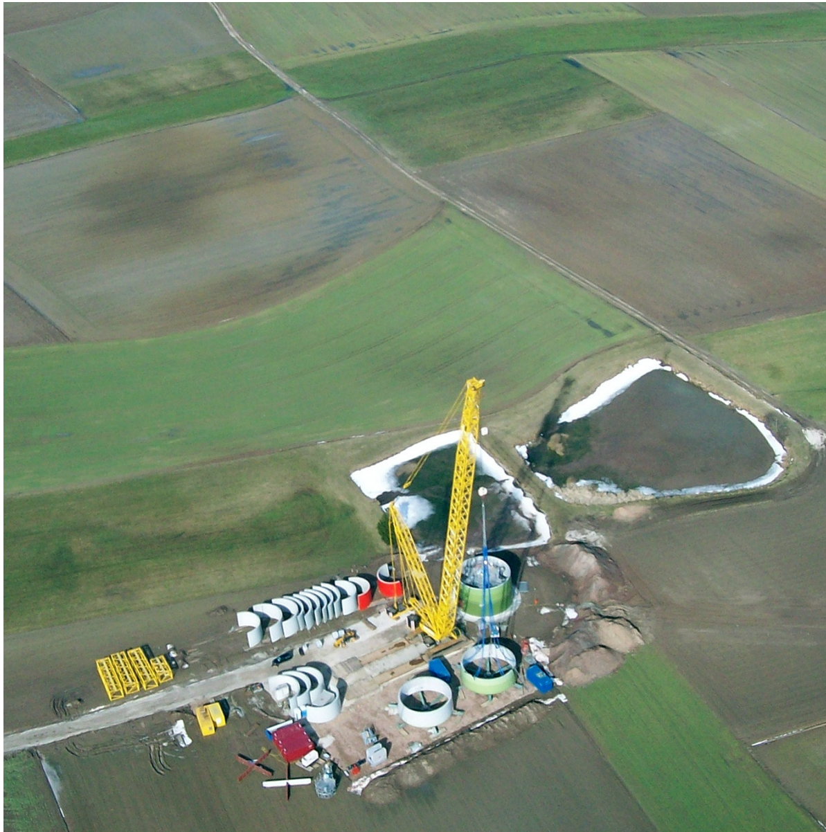
Luftbild von Baustelle WEA 1, ein Turmsegment wird von der Montagerüstung abgehoben.
