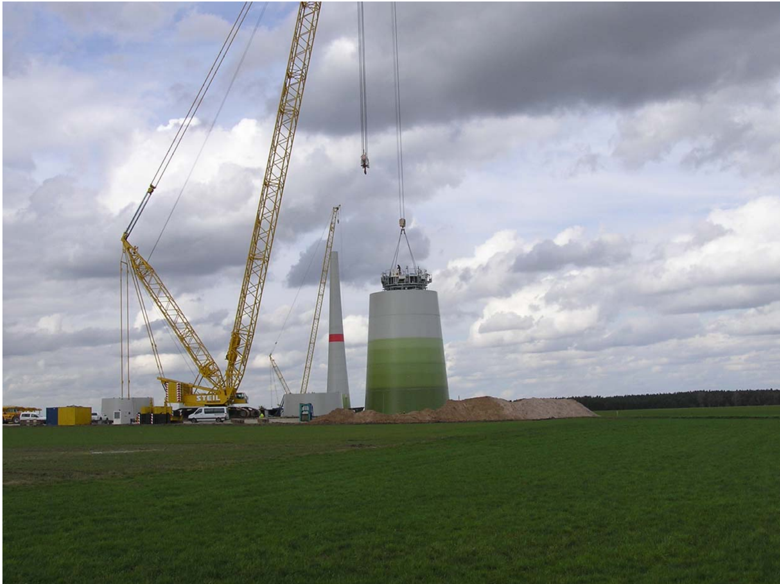
Einhub der Kletterschalung in WEA 2. Im Hintergrund der weitgehend abgeschlossene Turmbau von WEA 1.
