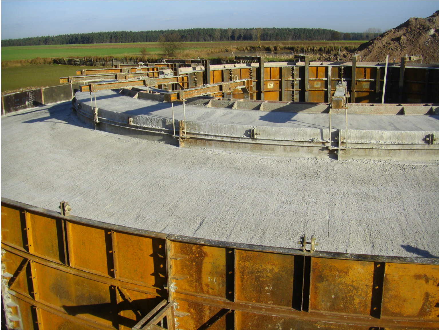
Blick auf Fundament nach abgeschlossener Betonierarbeiten
