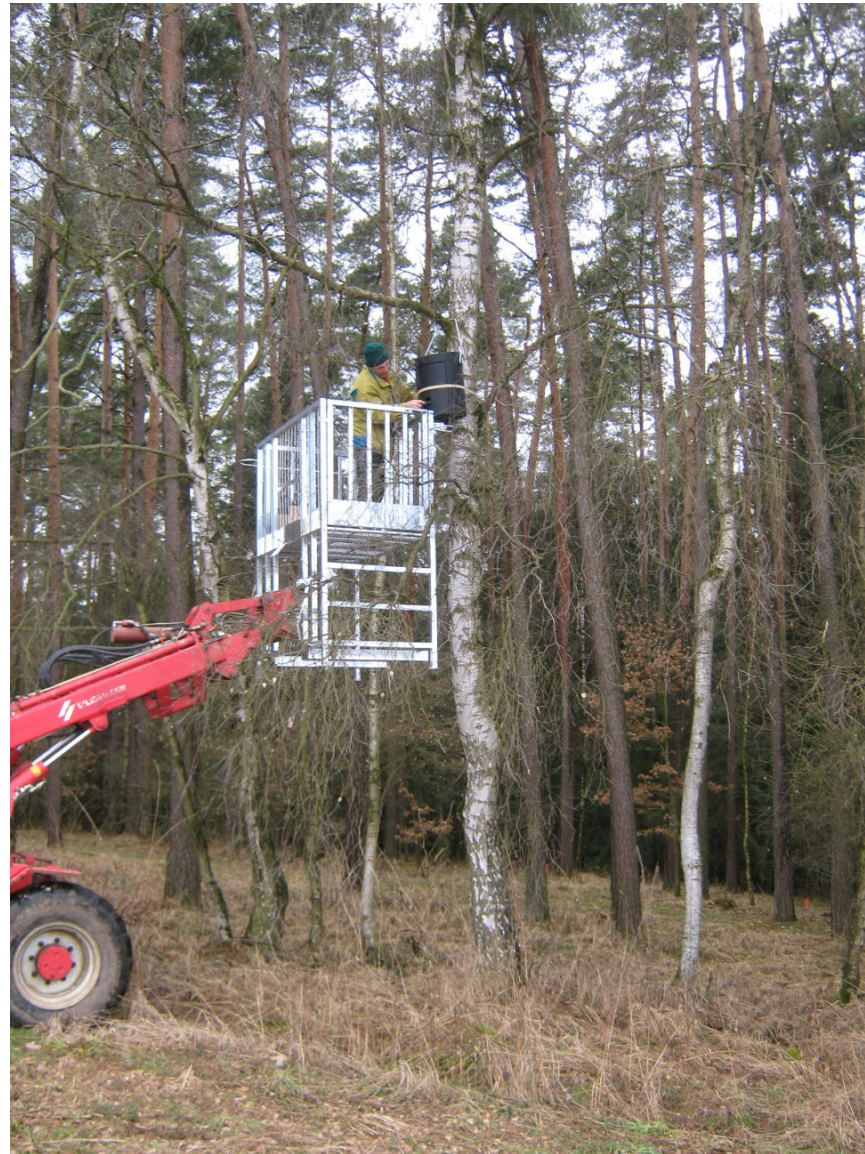
Montage von „Fledermaushöhlen“ am westlichen Ortsrand von Mausdorf
