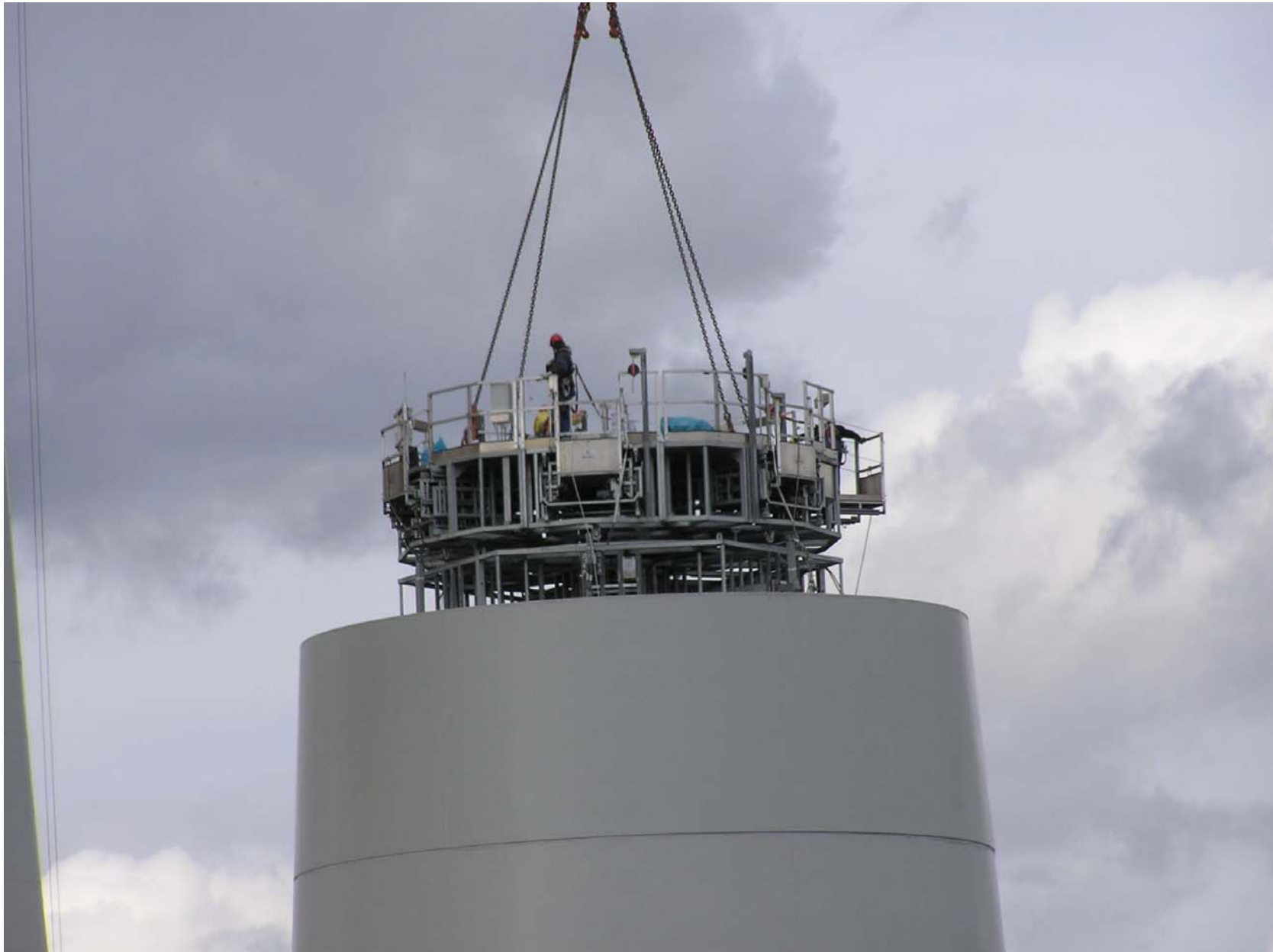
Kletterschalung über WEA 2 in luftiger Höhe
