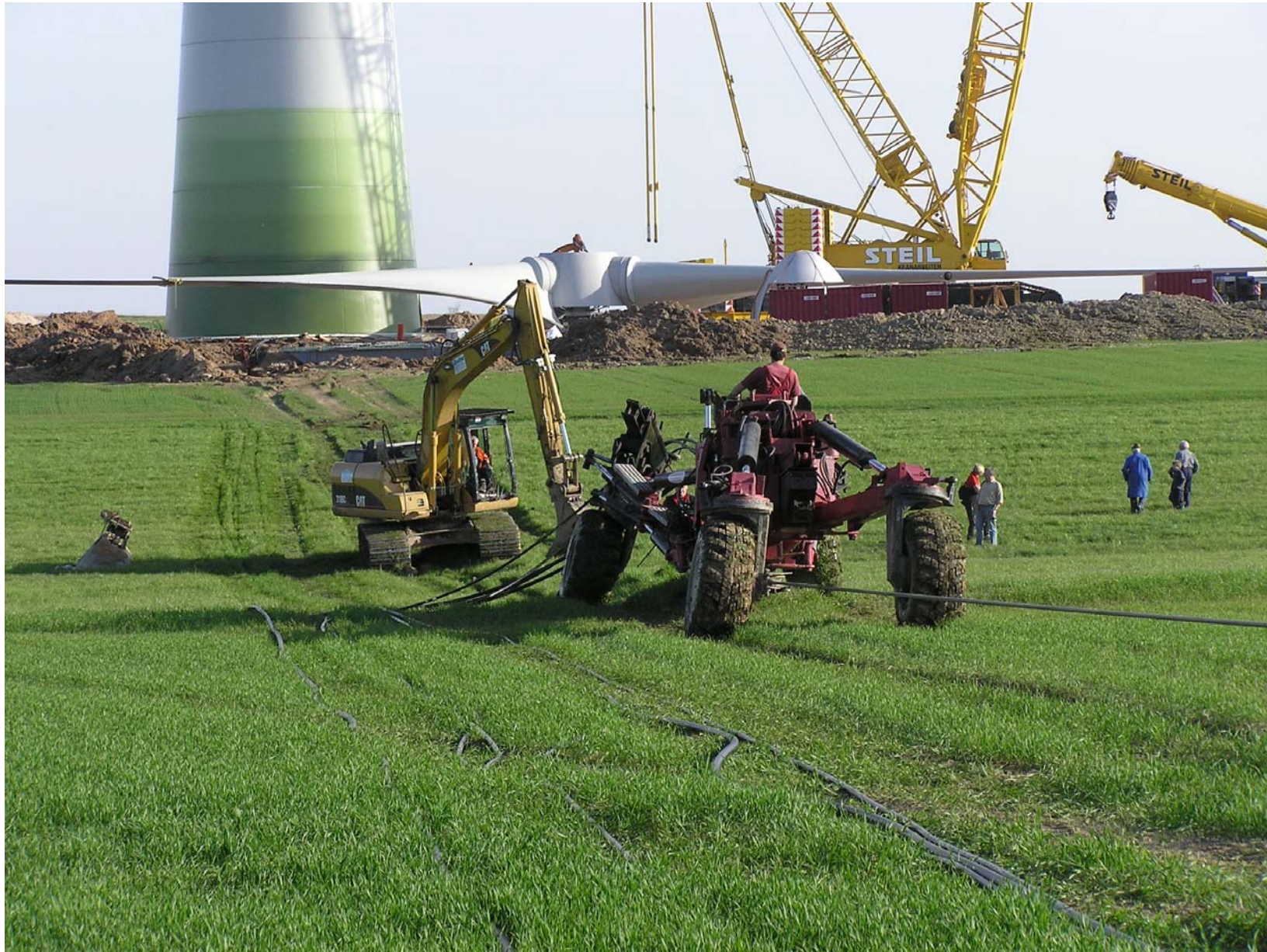
Kabelverlegung zwischen WAE 1 und WEA 2, im Hintergrund liegt der vormontierte Rotor von WEA 1 zum Hub bereit.
