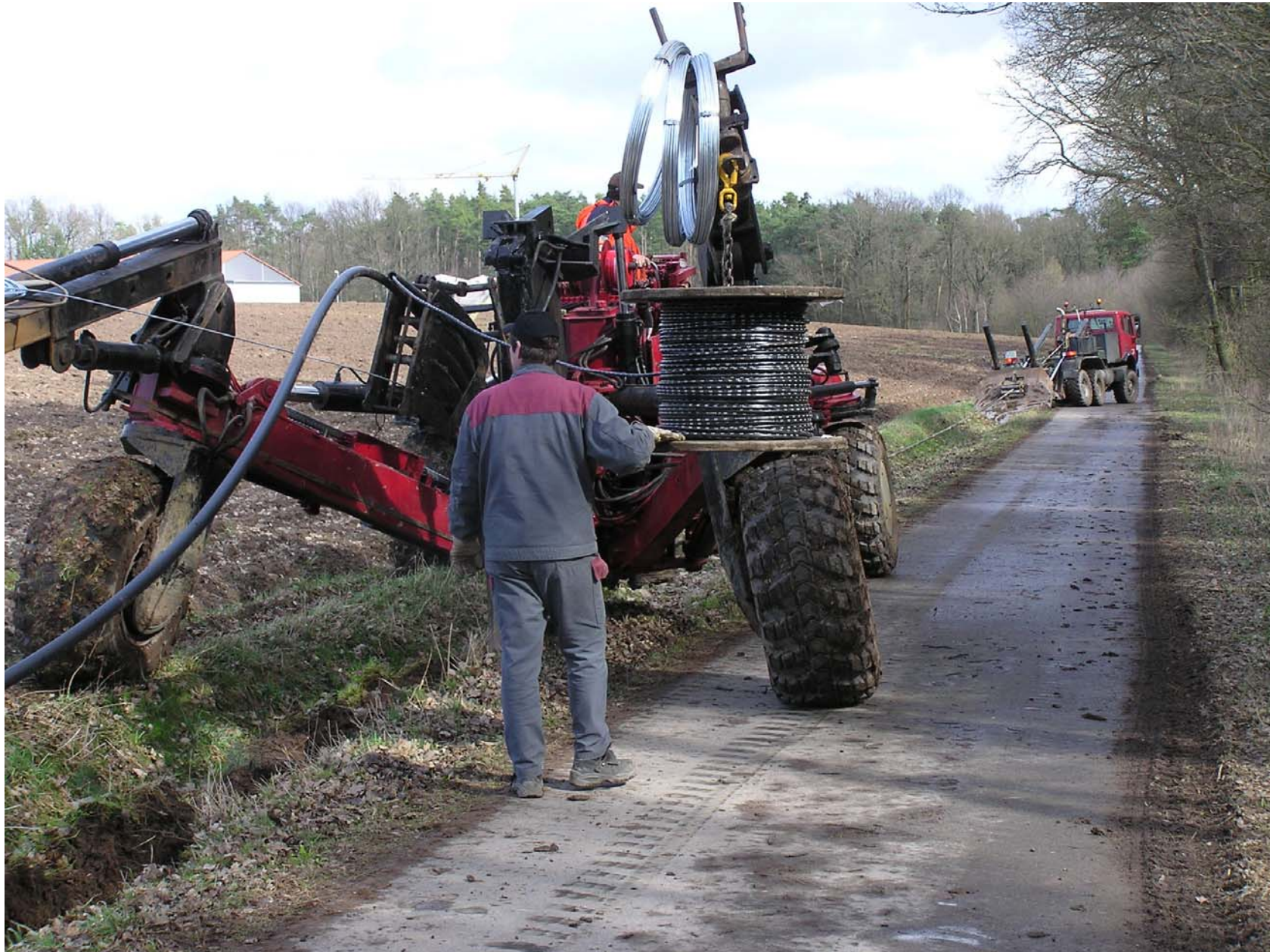
Kabelpflug in Aktion entlang des „Schlagweges“ von der Übergabestation Richtung Puschendorf
