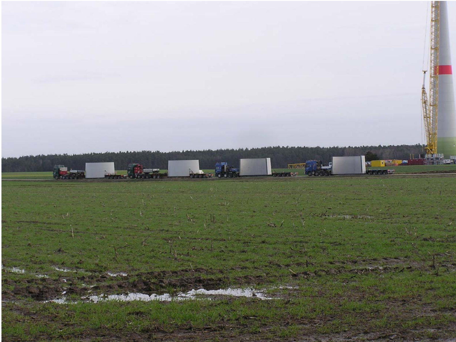
Antransport von Stahlbetonfertigteilen für die Turmmontage von WEA 2
