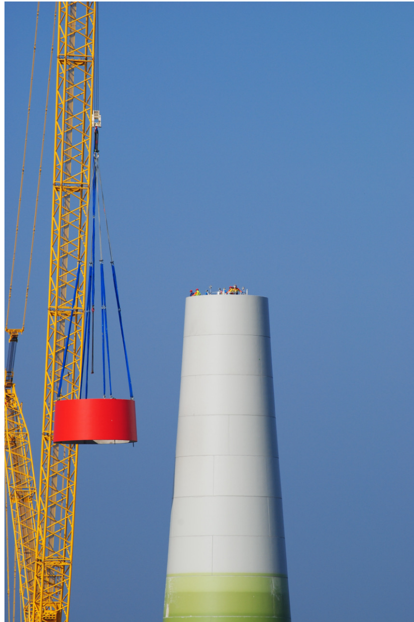
Montage eines Stahlbetonringes
