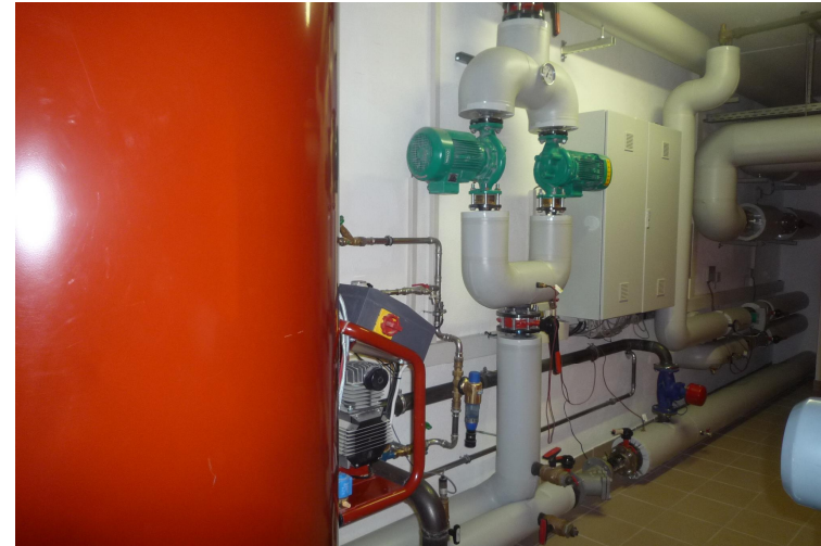
Heizraum, zentrale Netzförderpumpen
