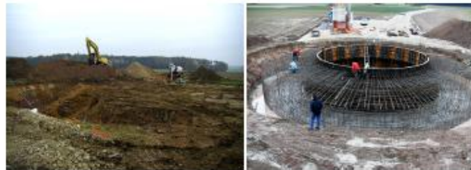
Erdarbeiten und Fundamentbau
