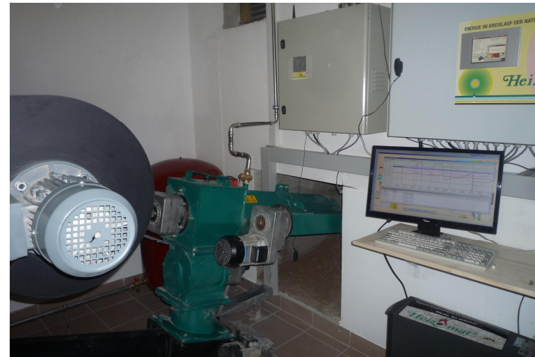
Heizraum, Hackschnitzelförderschnecke
