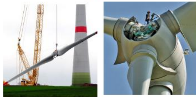
Generator und Rotormontage
