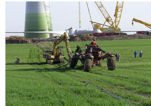
Stromleitungen werden in Eigenregie verlegt
